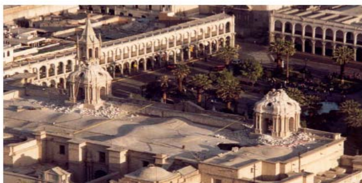
FIGURA 3 TORRES DE LA CATEDRAL DE AREQUIPA DAÑADAS POR EL SISMO DEL 2001
